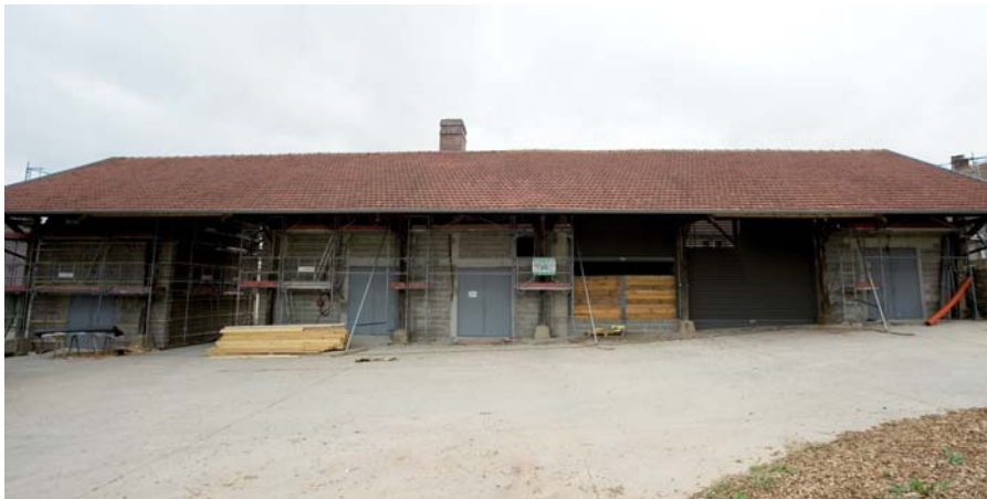
La chaufferie a été installée sous l'ancien hangar à matériels agricoles. A droite, derrière le rideau métallique, le stockage temporaire et quai de déchargement des plaquettes ; plus à gauche, le silo d'alimentation des chaudières ; la chaufferie est derrière les deux portes du centre de la façade.
