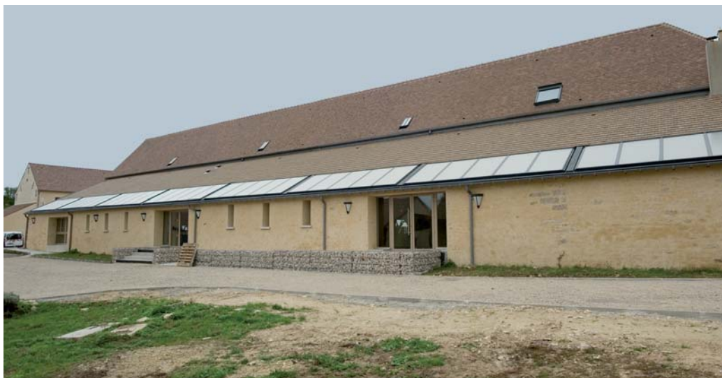
Les 96 m 2 de capteurs thermiques ont été placés le plus discrètement possible, après négociation avec l'Architecte des bâtiments de France. De fait, ils sont orientés au sud et reçoivent le rayonnement tard dans la journée.
